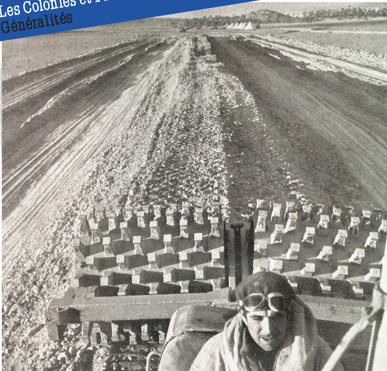
Construction du remblai de la ligne du chemin de fer Méditerranée-Niger entre Colomb-Béchar et Bou Arfa L'illustration 10 mai 1941
