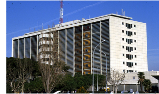
Hôpital Joseph Imbert à Arles
