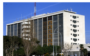
Hôpital Joseph Imbert à Arles
